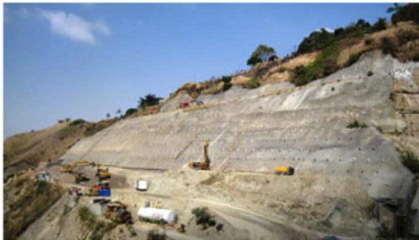
El Distribuidor estará conformado por un tramo en trinchera que se extenderá por el valle de la Qda. Macayapa desde la salida del Túnel (Portal Oeste) hasta la confluencia con la Qda. Tacagua, un terraplén de hasta 58 metros de altura sobre la Qda. Tacagua, y cuatro rampas en estructura, que distribuirán el tráfico entre los destinos.
